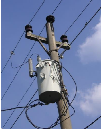
Gambar 5.8 Pemasangan trafo distribusi jenis cantol
