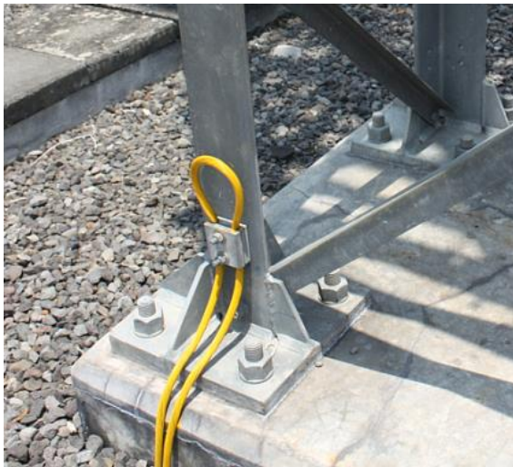
Gambar 4. 8 Terminal grounding di gardu induk
