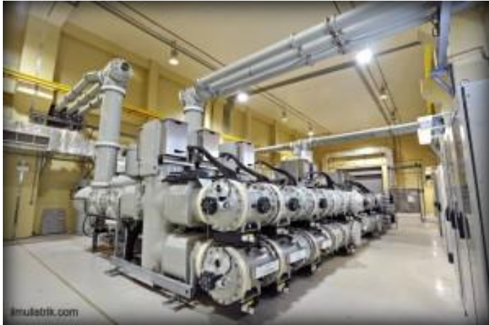
Gambar 4.4 Gardu induk dengan isolasi gas
