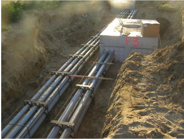
Gambar 3.2 Contoh pemasangan kabel saluran transmisi bawah tanah
