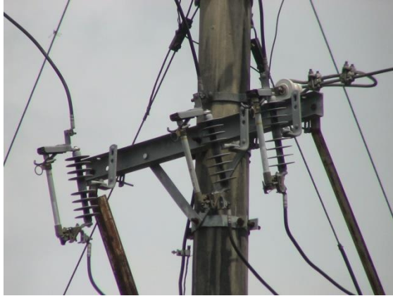
Gambar 5.6 Pemasangan FCO pada jaringan distribusi 3 fase
