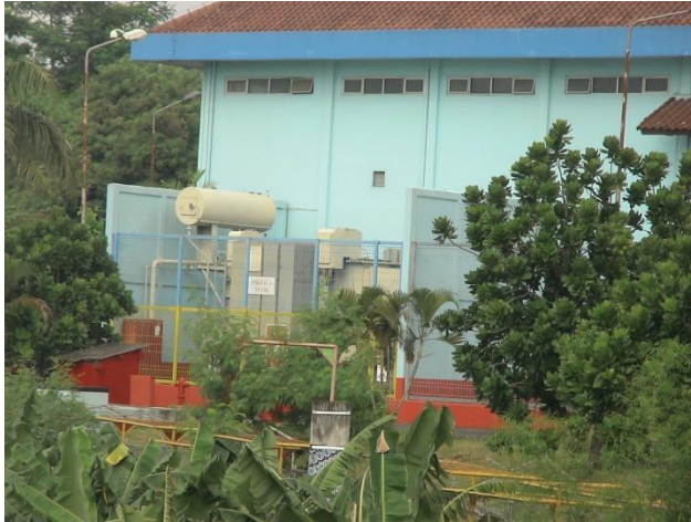
Gambar 4.3 Gardu induk tipe pasangan setengah luar
