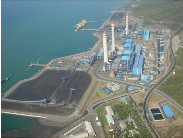
Gambar 2.6 PLTU batubara Paiton di Jawa Timur
