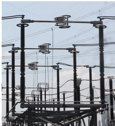
Gambar 4.6 Saklar pemisah tegangan ekstra tinggi
